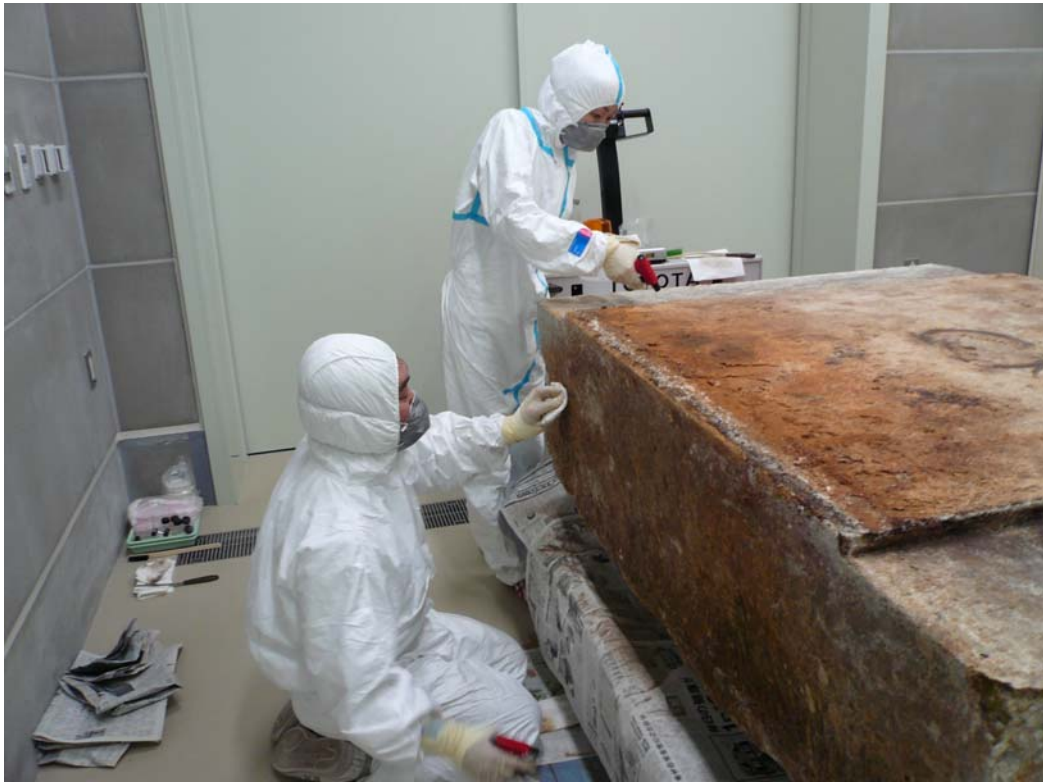
施設前室での汚れ除去作業
