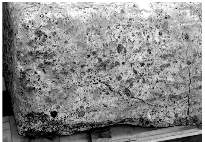
図 1.6. 床石 4 の西側面に発生している亀裂
