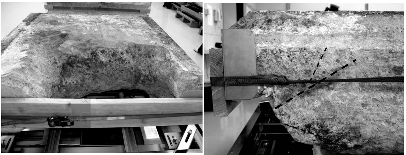
図 I-10. 保存修理施設で保管されている状態。石材を取り上げたときの、ベルトで拘束した状態になっているが、ベルトは一時的なもので、緩んでくると石材の自重でブロック状に崩落する危険がある。
