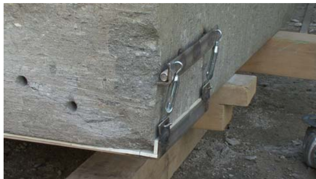
図 10. フレームとステンレス棒を調整金具で接続
