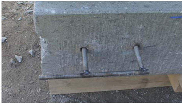
図 9. 支持用ステンレス棒を差し込んで一体化
