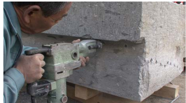
図 8. 支持棒を挿入するため、振動の少ないドリルにより孔をあける
