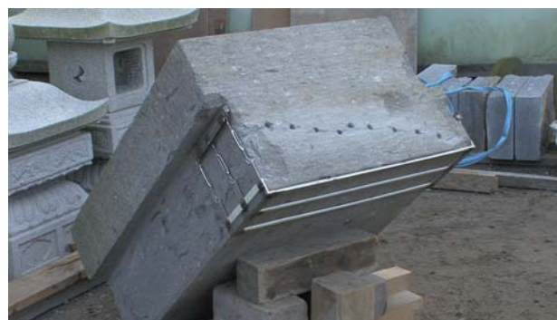
図 12. 側面下部（元位置）を受けるステンレスフレーム
