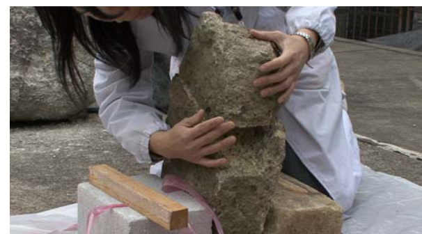
図 21. 欠損部が多く、硬化後に補填する
