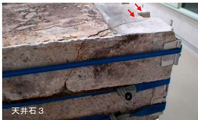
天井石 3 図 2. <分類Ⅱ> 相欠き部分のブロック状の割れ。ベルトで拘束しないと崩落する状態にある
