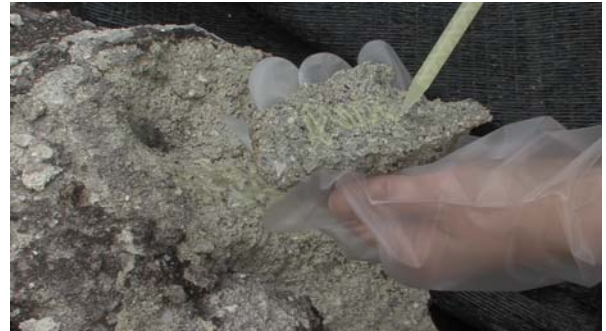
図 18. ガンを用いて主剤と硬化剤を混合
