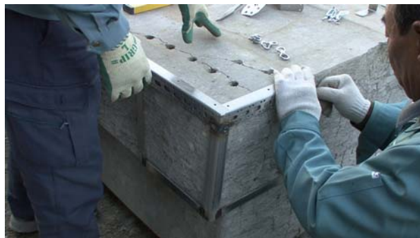
図 14. 形状にあわせてフレームを作る
