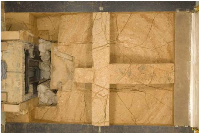
3 石室直上の亀裂
