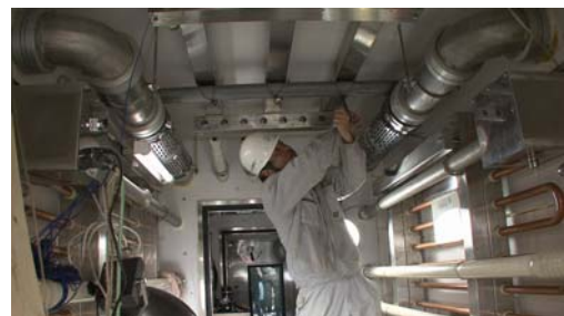
図 5. 作業の妨害となる配管類は撤去された。
