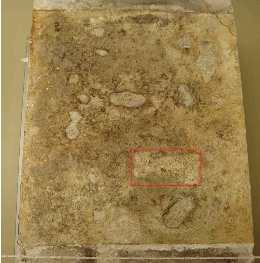
写真 11 天3クリーニング作業箇所
