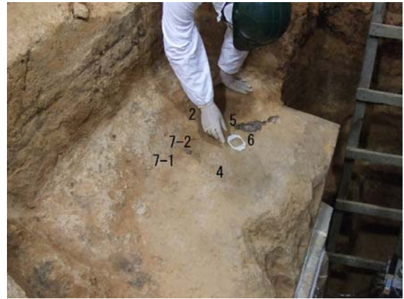
取合部石室天板石材表面黒色
