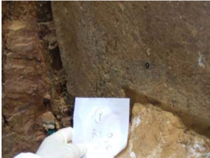
取合部天井石西側
