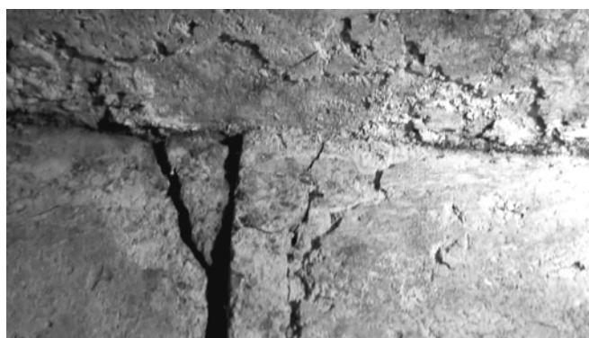
図 1.6 天井石3の取り上げに際して、東壁3、東壁2の上部にまたがる石材のブロック状の複雑な割れについても、落下の危険はある。ただし、漆喰はすでに落下していて残存しない状態にある。
