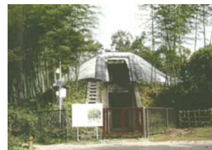
防水シート設置時の高松塚古墳
