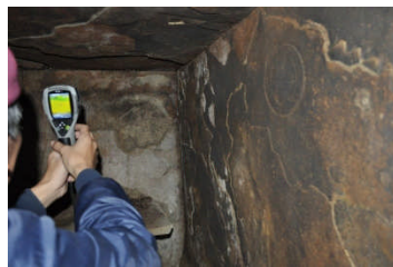
熱画像カメラによる調査
