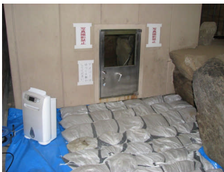
床面の被覆と除湿
