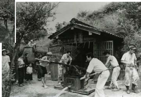
大雨の後、ポンプで水をくみ上げる。
