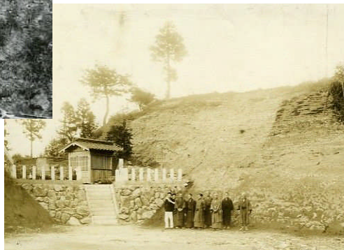
保存施設(覆屋)の建設と周辺整備
