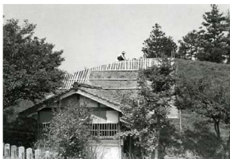
防水のため、便利瓦を貼る。
