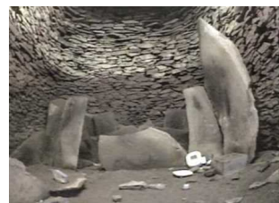
玄室被災状況
