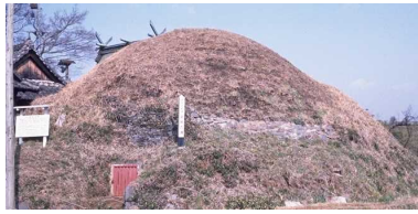
石室上部をコンクリートドームで覆い、 その上に土盛りを施す(昭和42年)
