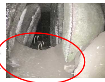
※入口部に土砂が堆積。
