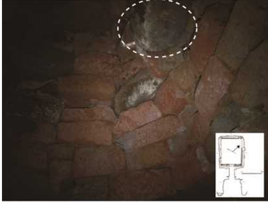
南側壁（奥側）天井付近石材の突出
