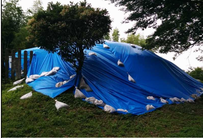
墳丘頂部に亀裂。開口部出口に向かって土の崩落。 ⇒ブルーシートで雨水対策。
