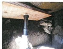
入口天井石のサポート
