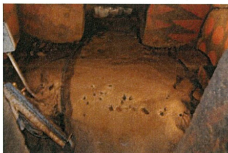
不織布敷設前(前室部)
