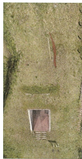
墳丘亀裂部(俯瞰)
