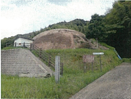
シート養生前 南東→北西
