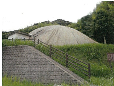
シート養生後 南東→北西
