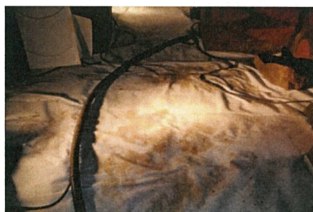
不織布敷設後(前室部)
