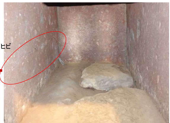
石棺内壁(左側)のひび割れと外傾
