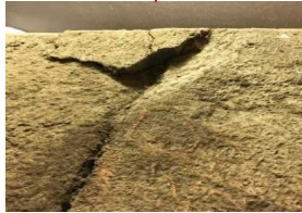
石棺蓋頂部棟木部破損状況
