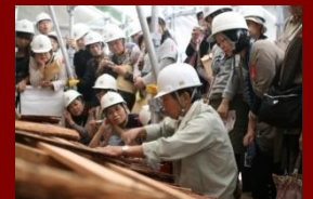
檜皮葺屋根の修復現場（宇佐神宮）
