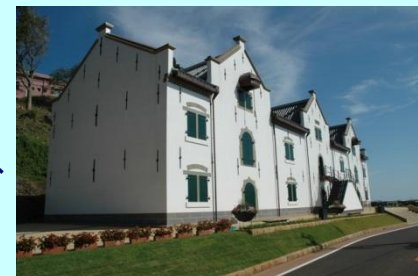
史跡「平戸和蘭商館跡」 建物復元整備（長崎県平戸市）
