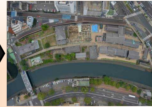
整備後(平成26年)
