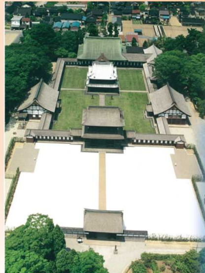
修理後（平成8年）
