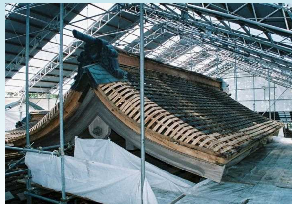
▲ 幣殿解体状況
