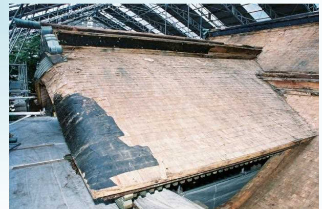
▲ 拝殿解体状況
