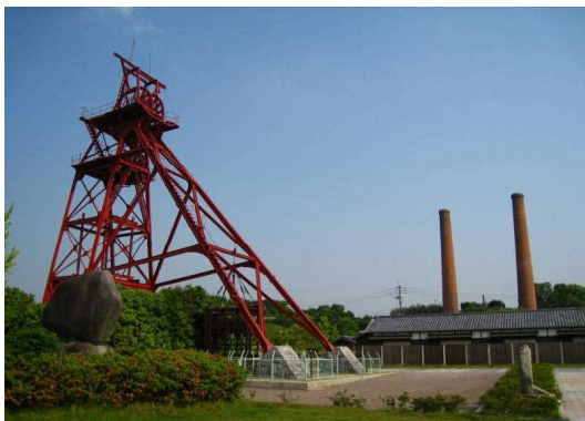
三井田川鉱業所伊田竪坑櫓と同第一・第二煙突
