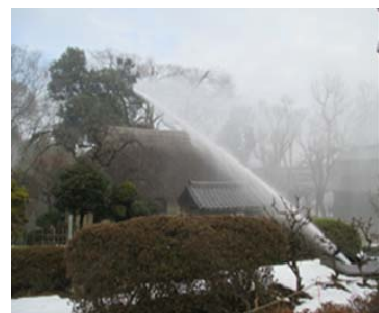
放水銃の作動試験
