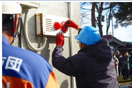
自動火災報知設備の発信機ボタンを押す (訓練時の様子)
