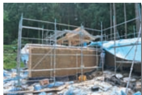
坊院（門と土塙）の復元工事
