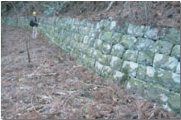
擁壁の計測風景（支線調査）
