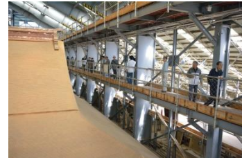
修理現場の見学
