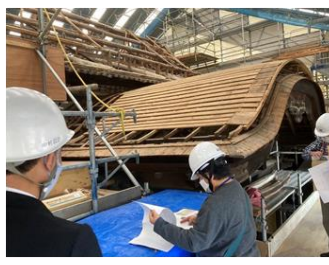
修理現場での見学風景
