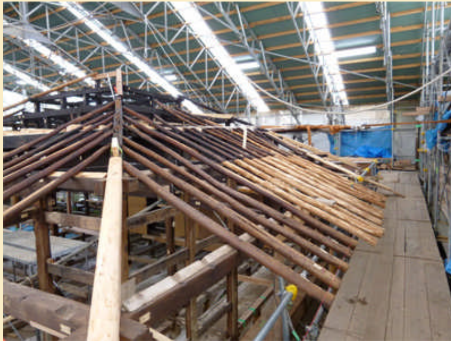
新垣家住宅保存修理現場
