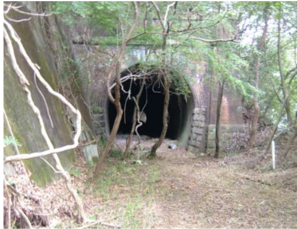
開拓後の3号トンネル
