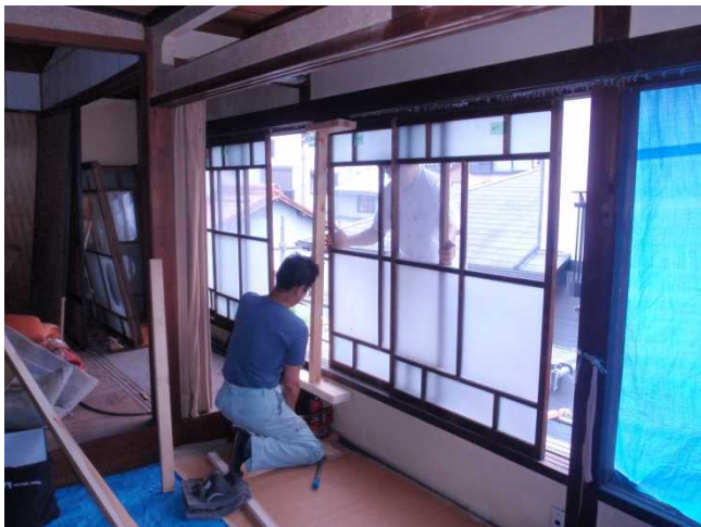
建具等修繕作業
