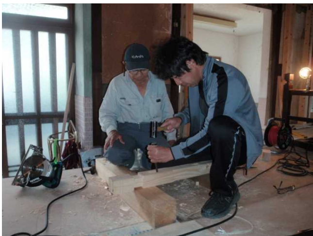
階段手すり取り付け (大工の指導によるWS)
