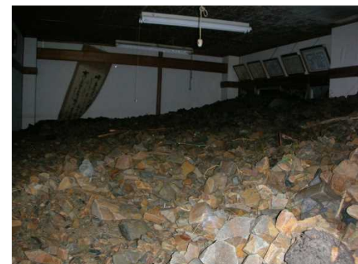
伝建地区の土砂災害
