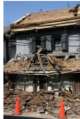
伝建地区の地震被害
