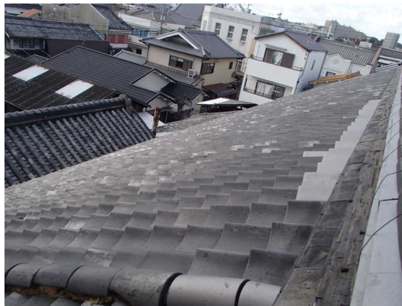
南面 土葺の屋根
