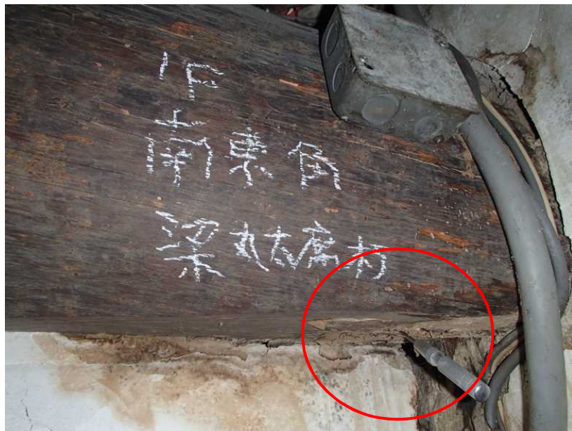
主要な構造部材の腐朽
