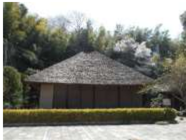
国指定重要文化財 旧石井家住宅
