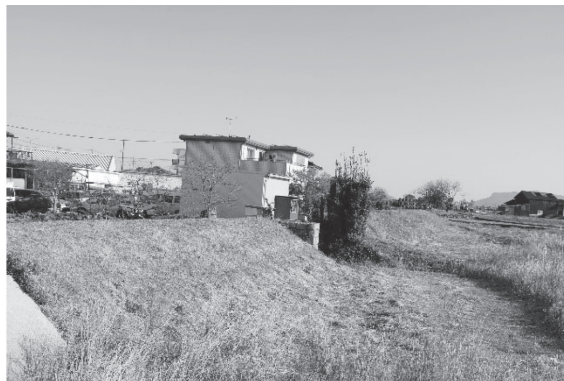
線路が通されていた盛土
