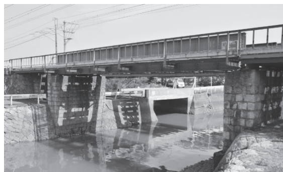
旧豊州鉄道の橋脚
