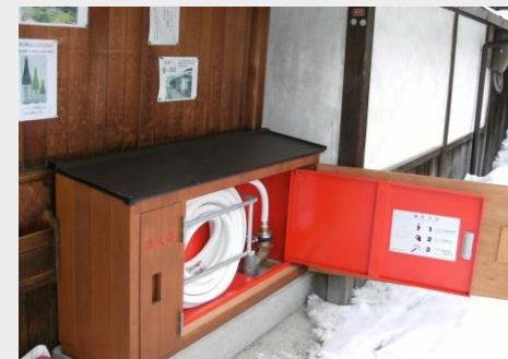
易操作性1号消火栓
