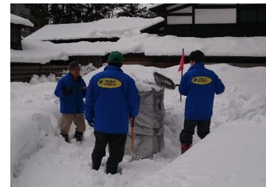
消防設備の除雪作業
