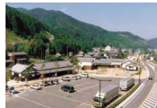
道の駅「若狭熊川宿」の整備(H11.5オープン)
