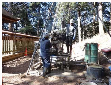
ボーリングによる地質調査
