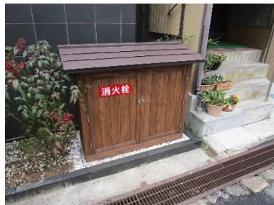
防災事業の例 (消火栓)
