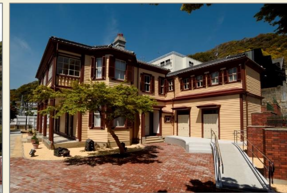
伝統的建造物／旧ドレウエル邸 (ラインの館) 昭和53年に市が取得 指定管理 無料公開 地区の案内センター・観光客向けトイレ
