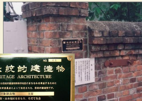
伝統的建造物の銘板設置
