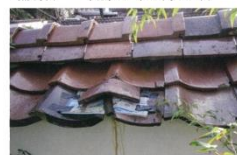
▲修理前の様子
