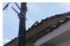
▲修理前の様子
