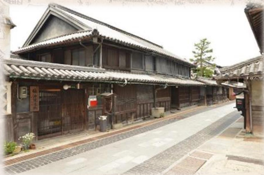
元禄4年(1691)建築の旧吉井家住宅
