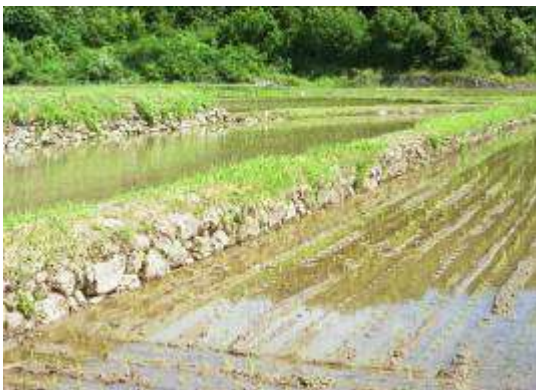
扇状地礫による畦の擁壁
