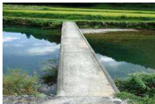
四万十川本流最上流の高樋沈下橋
