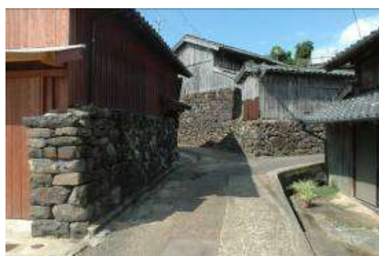
石積み擁壁が卓越する集落
