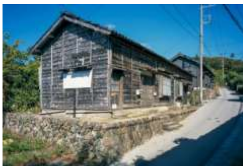
テラス状の敷地に建てられた鉱山住宅（上町）
