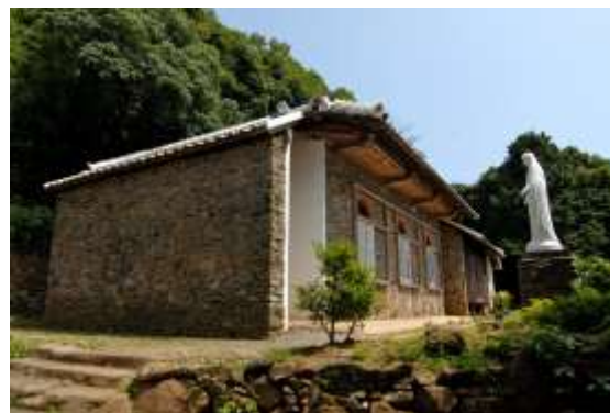
玄武岩が使用されている大野教会堂のド・ロ壁
