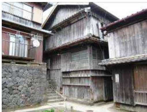
浦町地区の古民家と石垣
