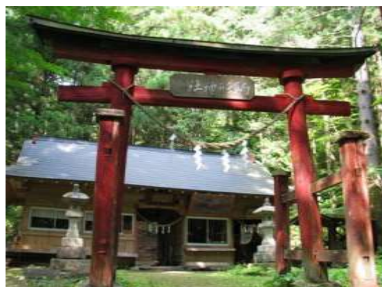
駒形神社の鳥居・拝殿・手水舎
