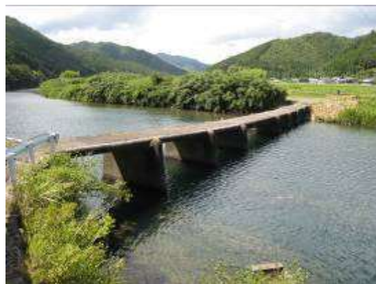
壱斗俵の沈下橋
