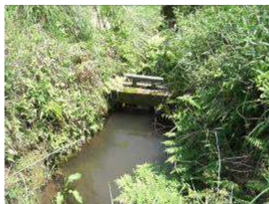
素掘りの 12 号水路と分水吐
