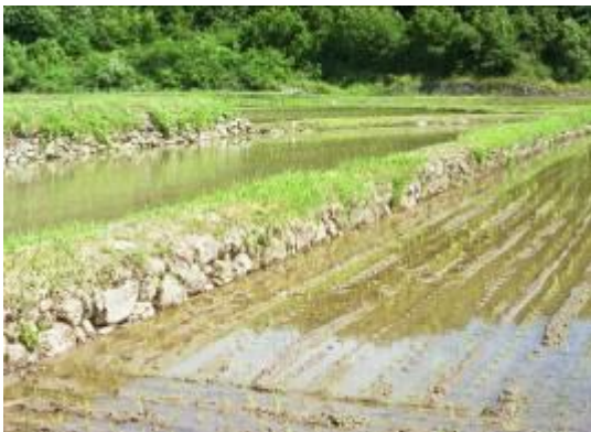
扇状地礫による畦の擁壁
