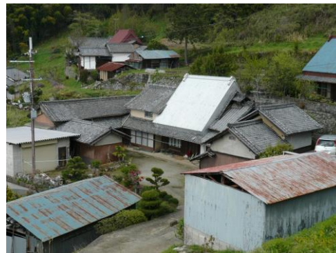
大和棟の家屋が卓越する入谷集落
