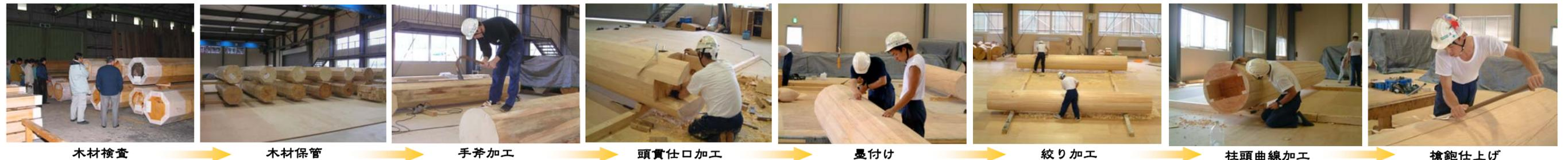
木材検査 → 木材保管 → 手斧加工 → 頭貫仕口加工 → 墨付け → 絞り加工 → 柱頭曲線加工 → 槍鉋仕上げ
