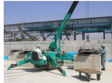
免震機構据付状況
