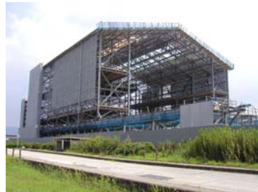
素屋根建設状況
