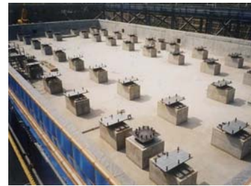
免震機構据付完了
