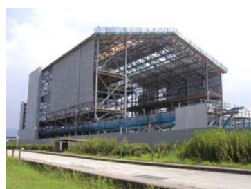
素屋根建設状況
