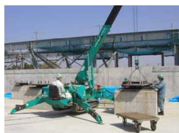
免震機構据付状況
