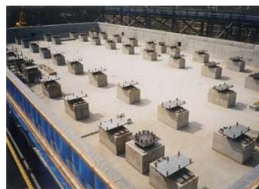
免震機構据付完了
