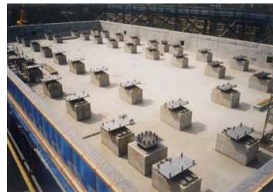
免震機構据付完了
