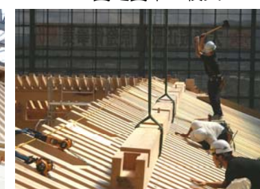
二重土居桁 組立
