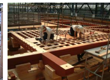
初重庇天井格子 組立
