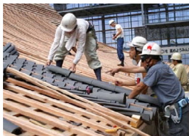
二重 平・丸瓦 試し葺き状況
