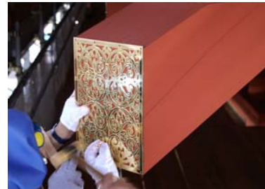
尾垂木木口金具 取付
