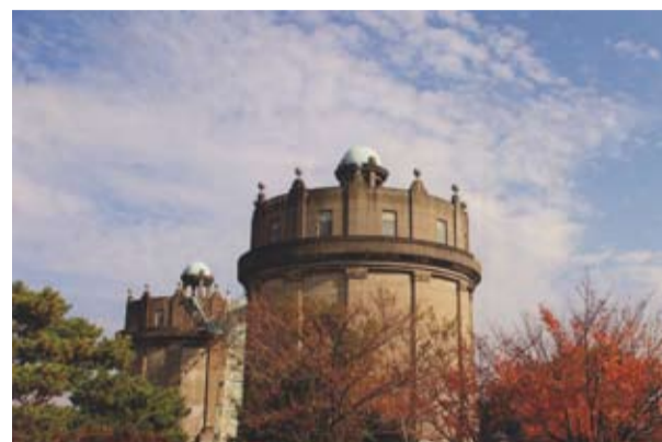
秋の給水塔風景
