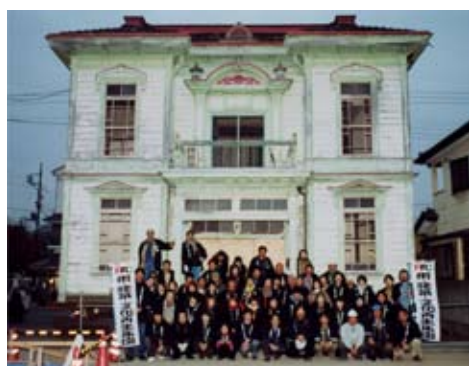
黒羽根内科医院旧館曳き家
