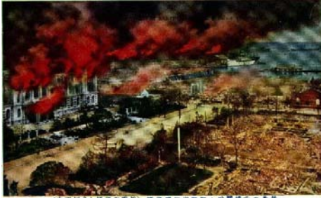
(大正12年1月1日) 関東大震災の被害の様子
